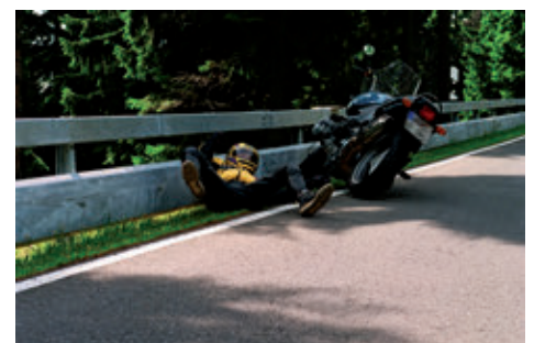
Figura 1: Esempio di una barriera di sicurezza in acciaio a nastro doppio, con un nastro tradizionale nella parte superiore e una protezione per i motociclisti nella parte inferiore (immagini per gentile concessione di Volkmann & Rossbach and PassCo)
