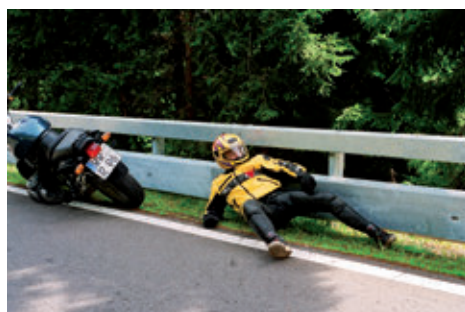
Figura 1: Esempio di una barriera di sicurezza in acciaio a nastro doppio, con un nastro tradizionale nella parte superiore e una protezione per i motociclisti nella parte inferiore (immagini per gentile concessione di Volkmann & Rossbach and PassCo)
