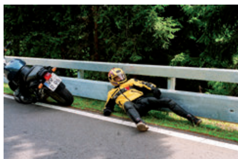
Figura 1: Ejemplo de una barrera de seguridad de acero de dos partes con guardarraíl superior tradicional y guardarraíl inferior adicional para la protección de los motociclistas (fotografías cortesía de Volkman & Rossbach y PassCo).
