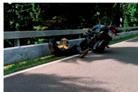
Figura 1: Ejemplo de una barrera de seguridad de acero de dos partes con guardarraíl superior tradicional y guardarraíl inferior adicional para la protección de los motociclistas (fotografías cortesía de Volkman & Rossbach y PassCo).
