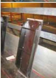
Obr. č. 2.09-1, 2.09-2, 2.09-3, 2.09-4, 2.09-5, 2.09-6 Príklady odporúčaných typov krytov drážok, ak sa používajú ako dištančné držiaky
