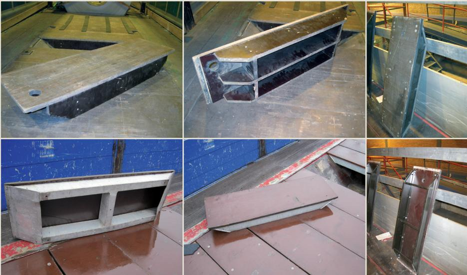
Fig. 2.09-1, 2.09-2, 2.09-3, 2.09-4, 2.09-5, 2.09-6 Eksempler på anbefalte typer av rennedecksler hvis de brukes som avstandsholdere
